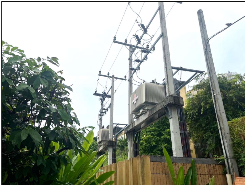
ภาพที่ 53 แสดงหม้อแปลงไฟ ฟัง บ้านพักชายทะเลใช้ร่วมกับฟัง โรงแรมวิรันดา จำนวน 2 เครื่อง
