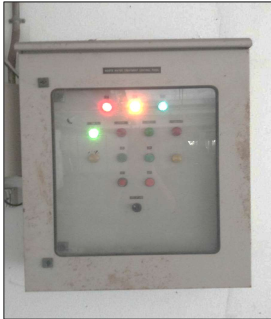
ภาพที่ 49 แสดงตู้คอนโทรลควบคุมการทำงานของเครื่องเติมอากาศ ฟัง โรงแรมวิรันดา
