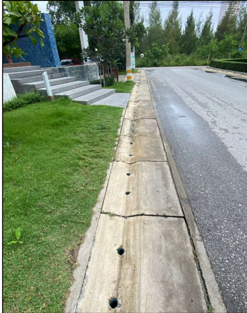
ภาพที่ 7 แสดงรางระบายน้ำภายในโครงการ
