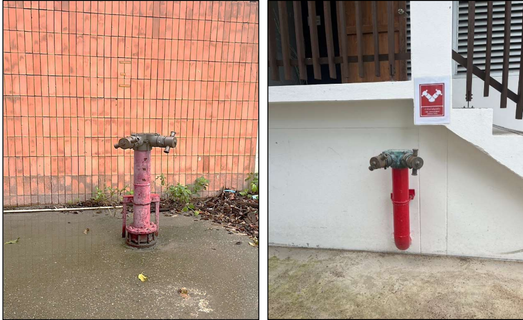
ภาพที่ 31 แสดงหัวรับน้ำดับเพลิง ฟังหัวหินพูลสวิต - ฟังบ้านพักชายทะเล
