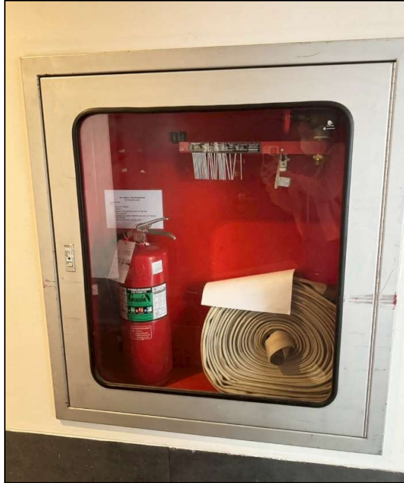
ภาพที่ 27 แสดงตู้เก็บสายน้ำดับเพลิง-ถังดับเพลิง
