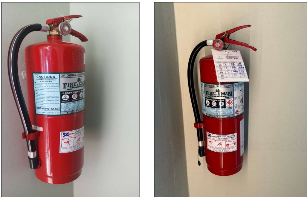
ภาพที่ 30 แสดงถังดับเพลิง - ตรวจสอบประจำเดือน
